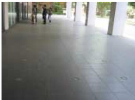
写真5 RFIDタグが埋め込まれた床
